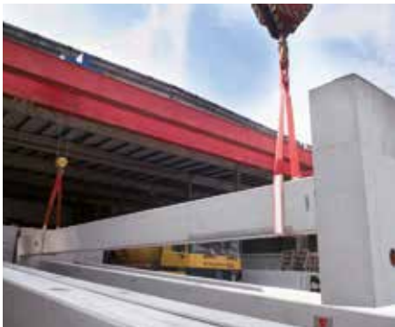
LASH+LIFT-Schutzschlauch SF-1 Schnittfeste secutex-Beschichtung schützt zuverlässig vor scharfen Kanten.
